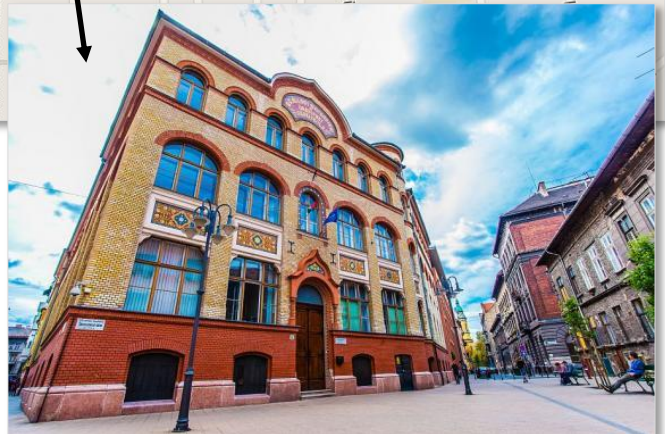
TB - Tavaszmező utca 15., District VIII. Kálmán Kandó Faculty of Electrical Engineering - KVK
