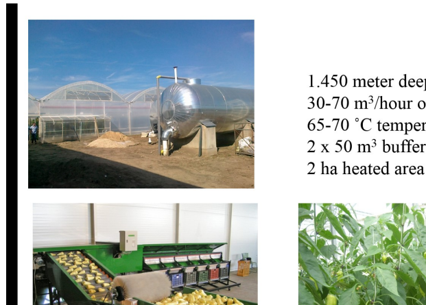
4. ábra. Geotermikus hőhasznosítás Szentesen, puffertartállyal, Bakó Dániel kertészete
